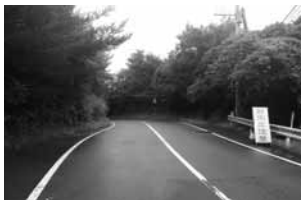
▲永浦～樋合線工事予定箇所
