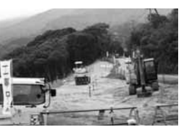
▲望薩峠の工事の様子
